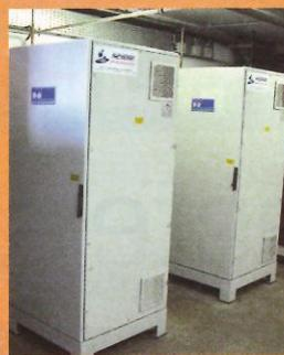
Deux équipements de production d'ozone [séparation de l'oxygène de l'air et transformation par voie plasma de l' $O_2$  en  $O_3$ ].
