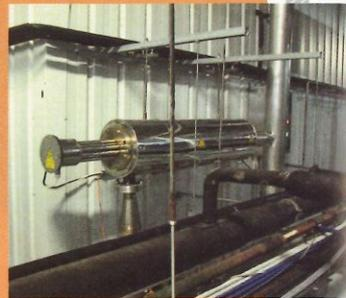
Installation de transformation catalytique de l' $O_3$  résiduel en  $O_2$  dans le plénum.
